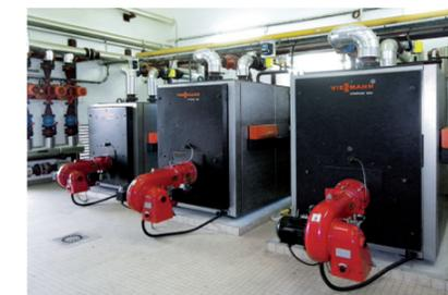
Chaudières gaz condensation Vitomax et basse température Vitoplex
