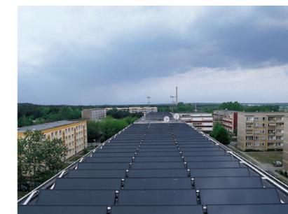
Capteurs solaires plans Vitosol
