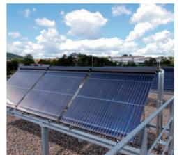
Capteurs solaires à tubes sous vide
